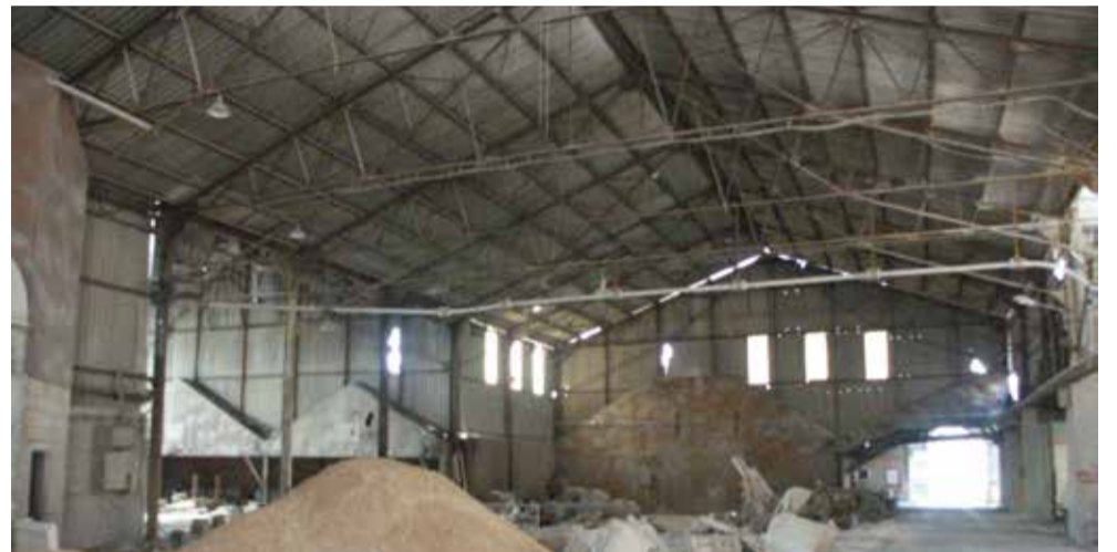
Charpente en métal dite "Eiffel", 1 ère du genre lors de la construction de l'usine et conservée jusqu'à la destruction des bâtiments du site nord.
